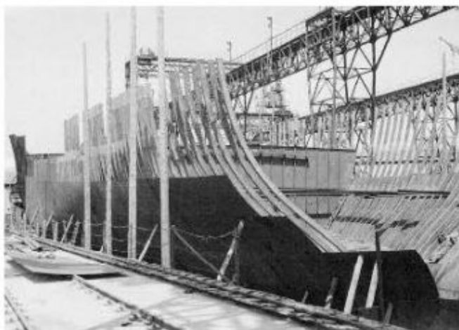
Mise en place des membrures.
