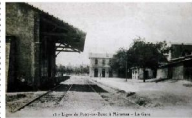
Vue sur le tracé de la ligne Miramas-Port de Bouc situé à l'extrémité de l'actuel quai de la Liberté. Arrière-plan - collection Grotton.
