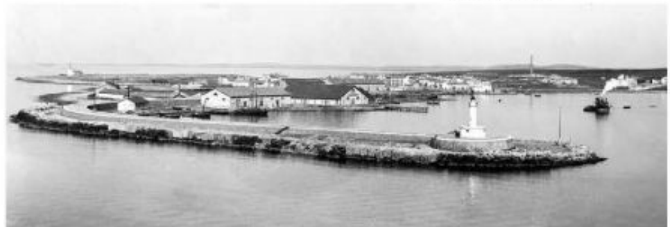
La construction de la jetée et de sa balise maritimes à ses débuts permit l'installation de quais de marchandises dans le radeau du port de Bouc. Les bâtiments derrière la jetée sont des hangars de la raffinerie de pétrole La Phocéenne (1888-1928). En fond, la cheminée de l'usine de soude et raffinage de plomb. Archives - collection Barbot
