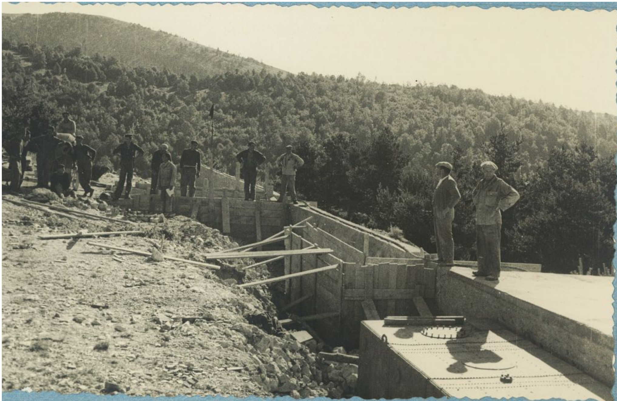
Mur de Soutènement & Cuve à Mazout
