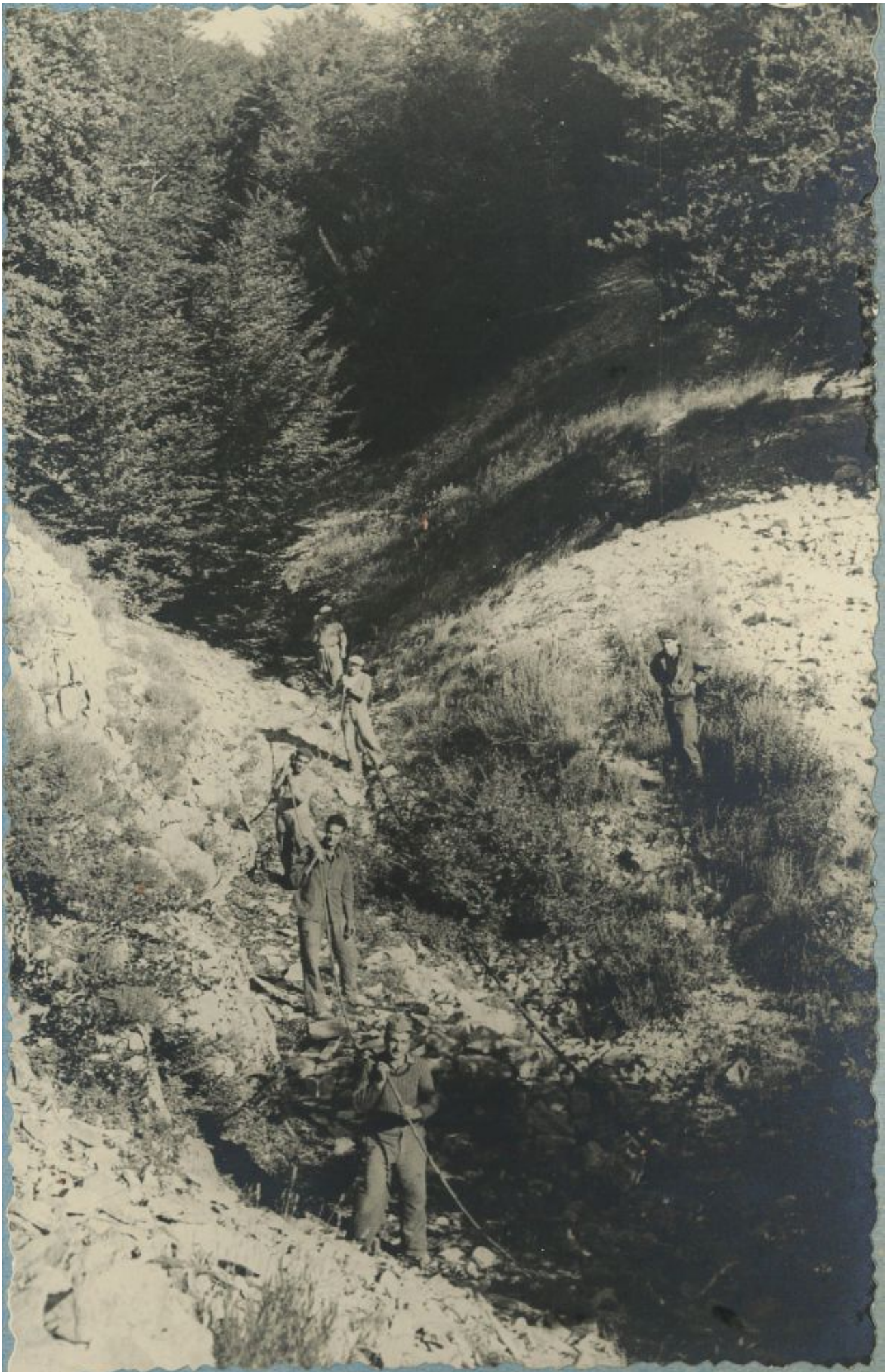
Montage du Cable Electrique
