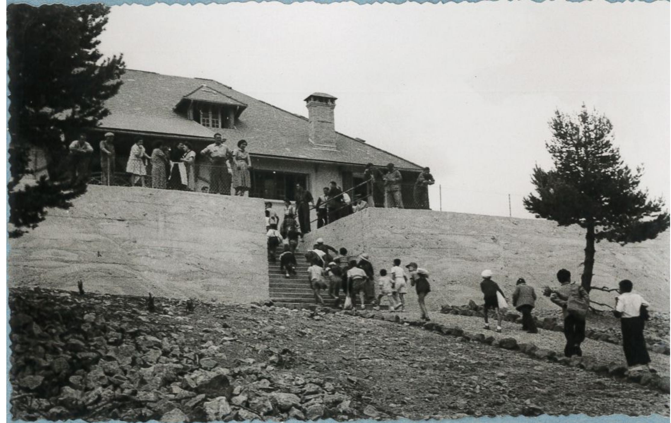
Chalet & Mur de Soutènement
